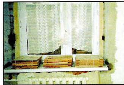
Подоконник приклеиваем на монтажную пену и до ее высыхания прижимаем грузами.
