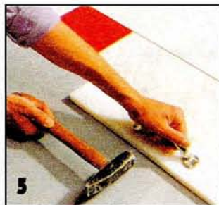
5 Одну доску подгоняют к другой с помощью монтажного бруска и молотка, не повреждая при этом ее гребень.
