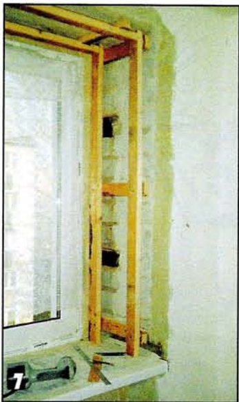
7 Несущей конструкцией для обшивки откосов служит обрешетка из брусков.
