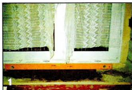
Маяки из цементного раствора выровнены по столбикам, склеенным из обрезков керамической плитки.
