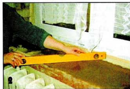
Стяжка, залитая по двум протяженным маякам, получается ровной.
