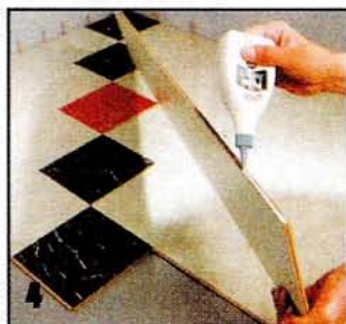
4 Уложив следующий декоративный элемент, снова стелят доски полной длины (120 см).
