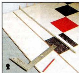
2 Кромка последнего элемента темного ряда задает длину начального элемента следующего, светлого ряда.
