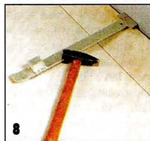
8 Раскроенную по ширине последнюю доску подгоняют к предшествующей с помощью стяжки.
