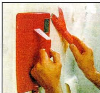
Так называемый обойный скребок позволяет легко удалить обои, не повреждая основы.
