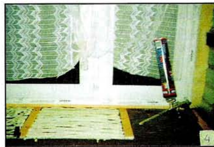
В пространство между планками наносим монтажную пену тонким слоем.
