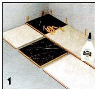
1 Первый квадратный элемент кладут у стены так, чтобы следующие аналогичные элементы расположились по диагонали.
