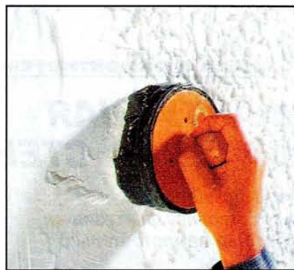
Аналогичную фактуру дает подушечка. При вращении ее получается узор «в кружочек».
