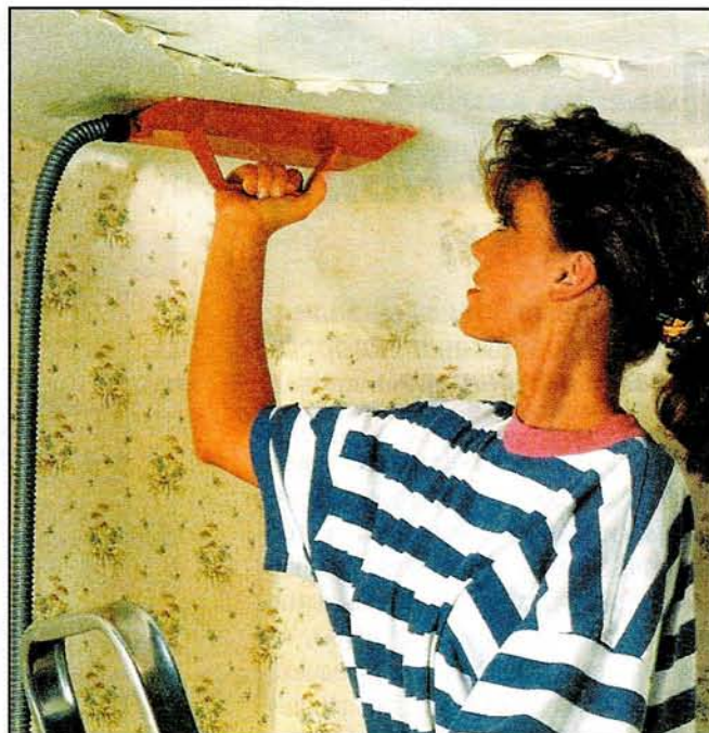
Легко можно удалить обои, в том числе с потолка, с помощью устройства — отпаривателя.
