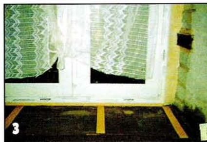
Опорой для подоконника служат фанерные планки толщиной 9-10 мм, прикрепленные к стяжке.
