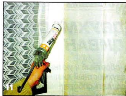
11 Зазоры между плиткой и пластиковым окном заполняем силиконовым герметиком,...
