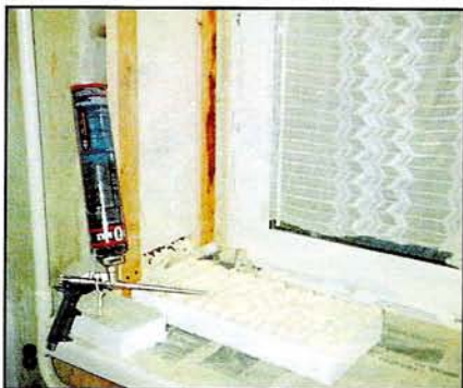
10 Пустоты в обрешетке заполняем монтажной пеной и пенопластом.
